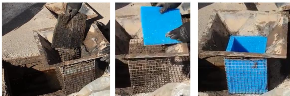
Figura 4 Sostituzione filtro a coalescenza (si esegue in 60 secondi)
